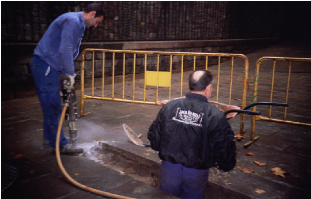
Fotografia 1: Inici de l'excavació a la plaça Canonge Colom.
