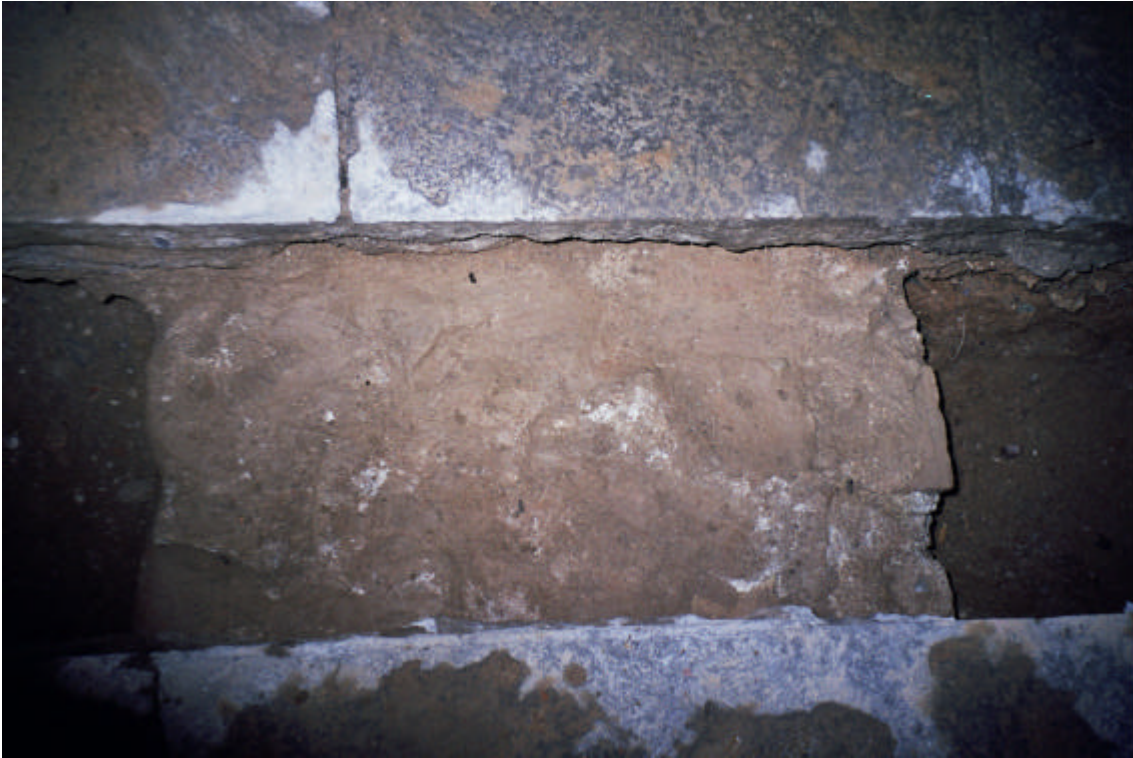
Fotografia 4: Vista de la longitud total del mur U. E. 103.
